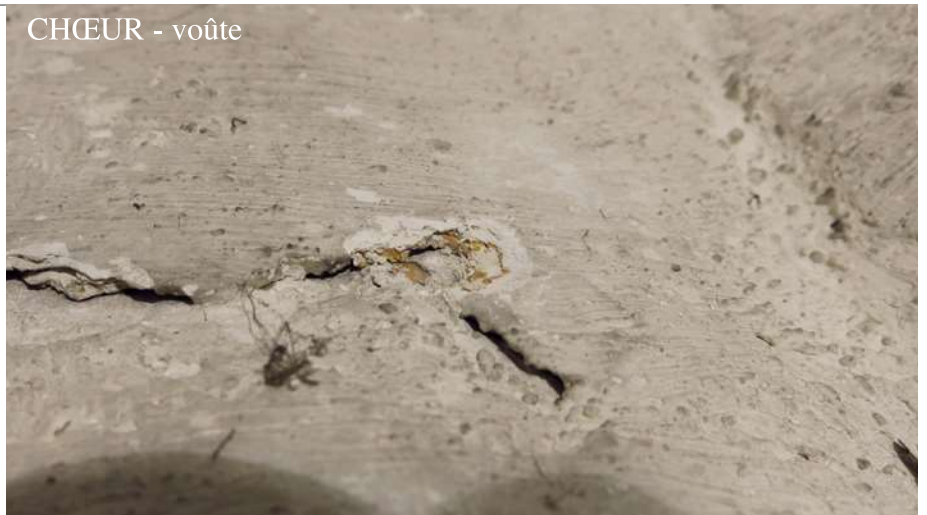
Ci-dessus: C S6 Clé, tambour, partie haute, sous le voûtain. Dans la lacune du badigeon apparent on aperçoit de l'ocre jaune.
