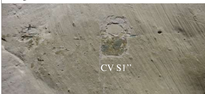
Ci-dessus: CV S1', sur le bord inférieur du tambour - rouge sous le badigeon.
