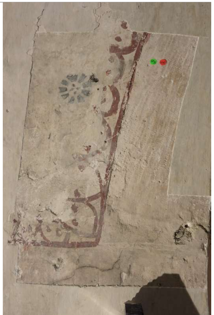
Sondage S S10, mur S, encadrement de la baie, côté E, naissance de l'arc : dégagement du décor du XVIe s. - faux appareil rose de l'encadrement et bandeau décoratif accompagnant l'arc.
