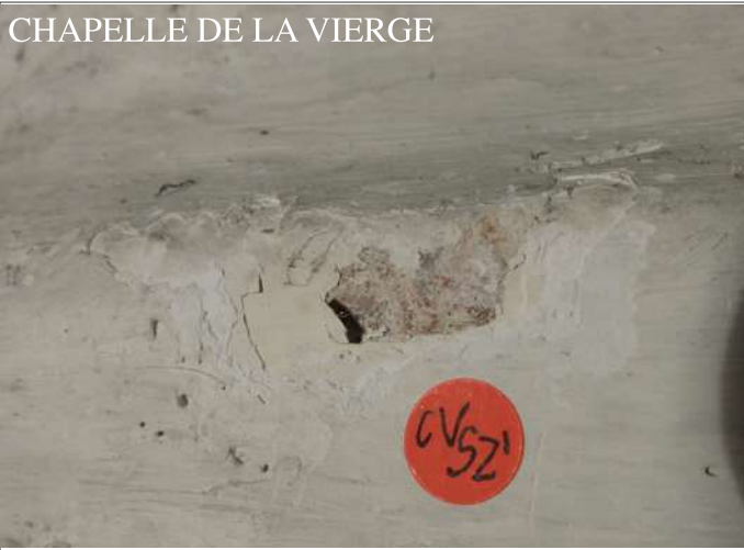
Ci-dessus: CV S2 , sur la gorge inférieure, à ~12 cm de la clé de voûte : couche rouge sur la pierre, encrassement (et peut-être restes de noir ?).
