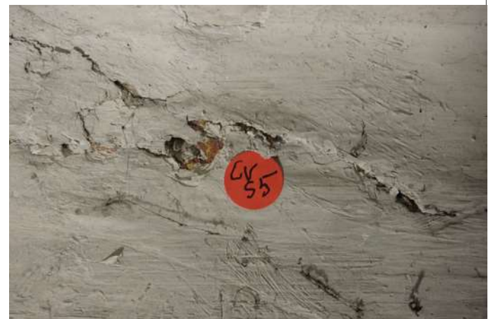
CV S5 - Enduit raccord arc/voûtain, craquelé : couche de rouge (superposée ici à une couche d'ocre jaune)
