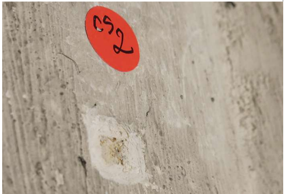
Ci-dessus: C S6 Clé, tambour, partie haute, sous le voûtain. Dans la lacune du badigeon apparent on aperçoit de l'ocre jaune.
