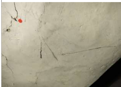
N3 S6 ~dans l'axe vertical, à ~50 cm de la voûte - dito S4 Enduit XVIIIe s., surface blanc ocré, dépôts gris (poussières). Deux couches de badigeons superposées (XVIIIe et XIXe s.?).
