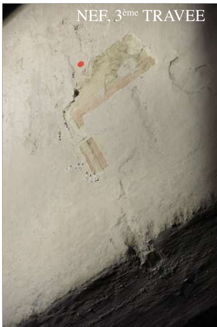
Mur est, front de l'arc, sondage N3 Sa mettant en évidence le faux appareil.
