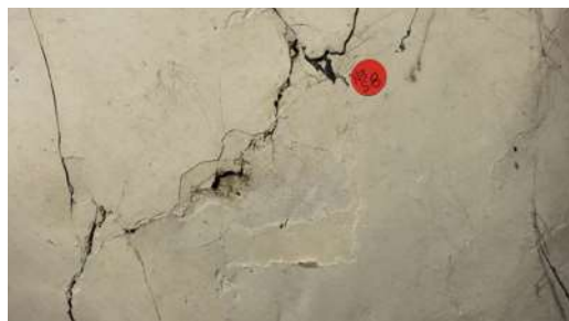
N3 S6 ~dans l'axe vertical, à ~50 cm de la voûte - dito S4 Enduit XVIIIe s., surface blanc ocré, dépôts gris (poussières). Deux couches de badigeons superposées (XVIIIe et XIXe s.?).
