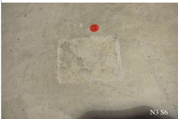
N3 S6 ~dans l'axe vertical, à ~50 cm de la voûte - dito S4 Enduit XVIIIe s., surface blanc ocré, dépôts gris (poussières). Deux couches de badigeons superposées (XVIIIe et XIXe s.?).
