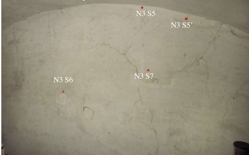
N3 S5 et S5' Jonction voûte/mur nord: enduit XVIIIe s. et deux badigeons superposés.
