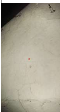
N3 S9 en bas, au-dessus de l'arc - enduit XVIIIe s. et deux couches de badigeons.
