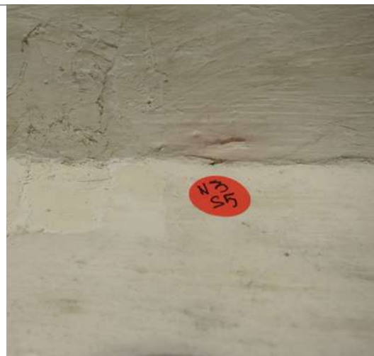
N3 S5 et S5' Jonction voûte/mur nord: enduit XVIIIe s. et deux badigeons superposés.
