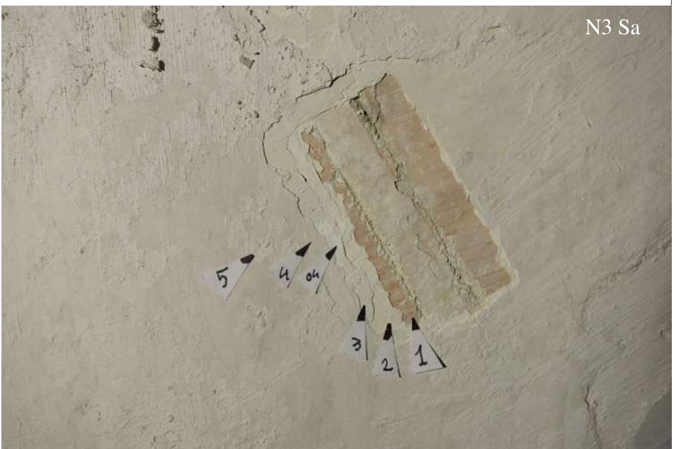
Mur est, front de l'arc, sondage N3 Sa mettant en évidence le faux appareil.
