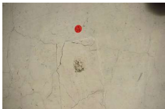
N3 S9 en bas, au-dessus de l'arc - enduit XVIIIe s. et deux couches de badigeons.
